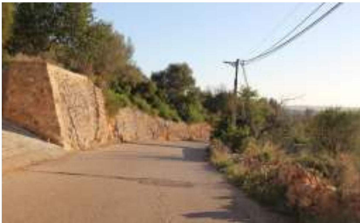
FOTOGRAFIA 6. Murs de pedra en sec al camí de Ses Olleries.
