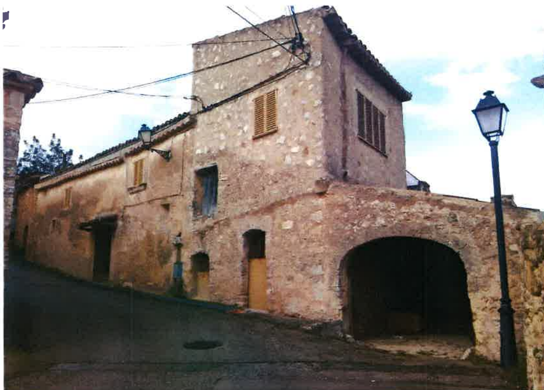
FIGURA 4. Cas Gorrió exemplifica el tipus de construcció de Ses Coves, amb tancaments de maçoneria ordinària de la pedra calcària irregular del lloc.
