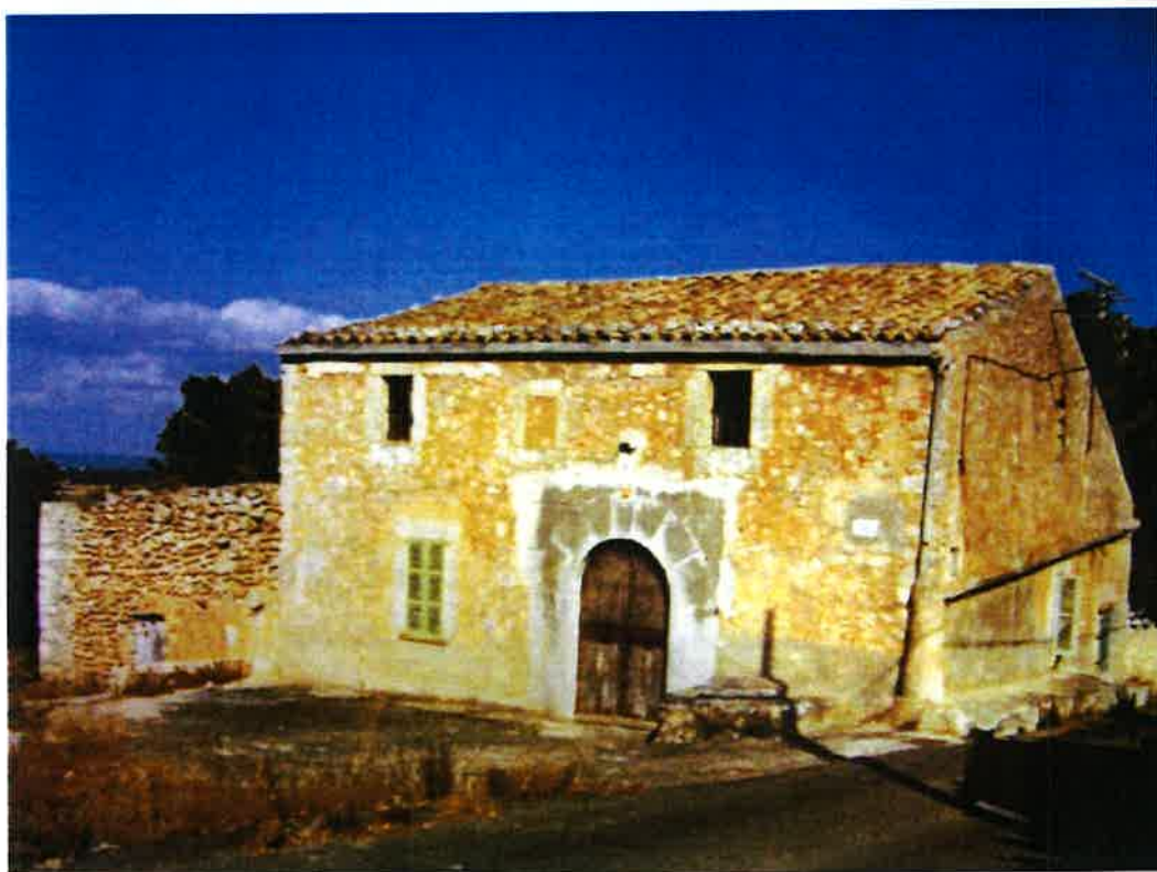
Estat original, anterior a la reforma
