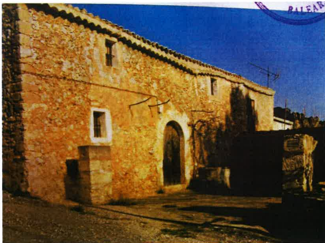
Estat original anterior a la intervenció
