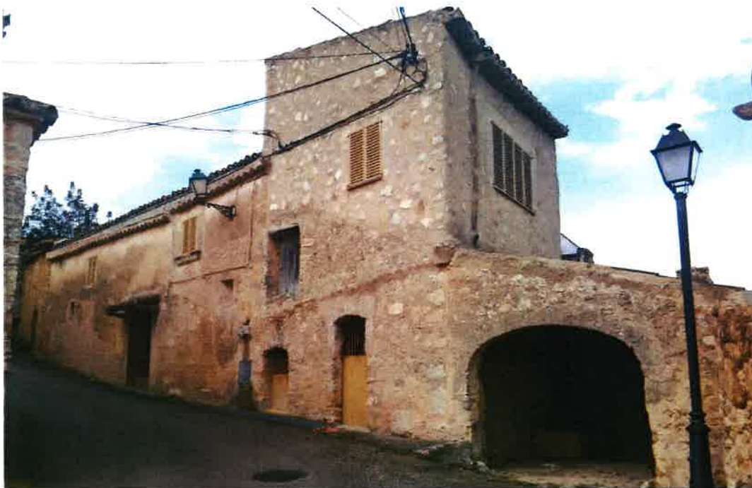
Figura 18: Cas Gorrió exemplifica el tipus de construcció de Ses Coves, amb tancaments de maçoneria ordinària de la pedra calcària irregular del lloc.
