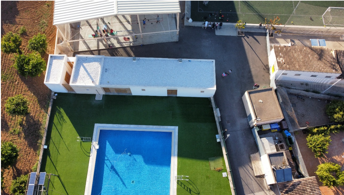
Coberta plana a ubicar captadors fotovoltaics
